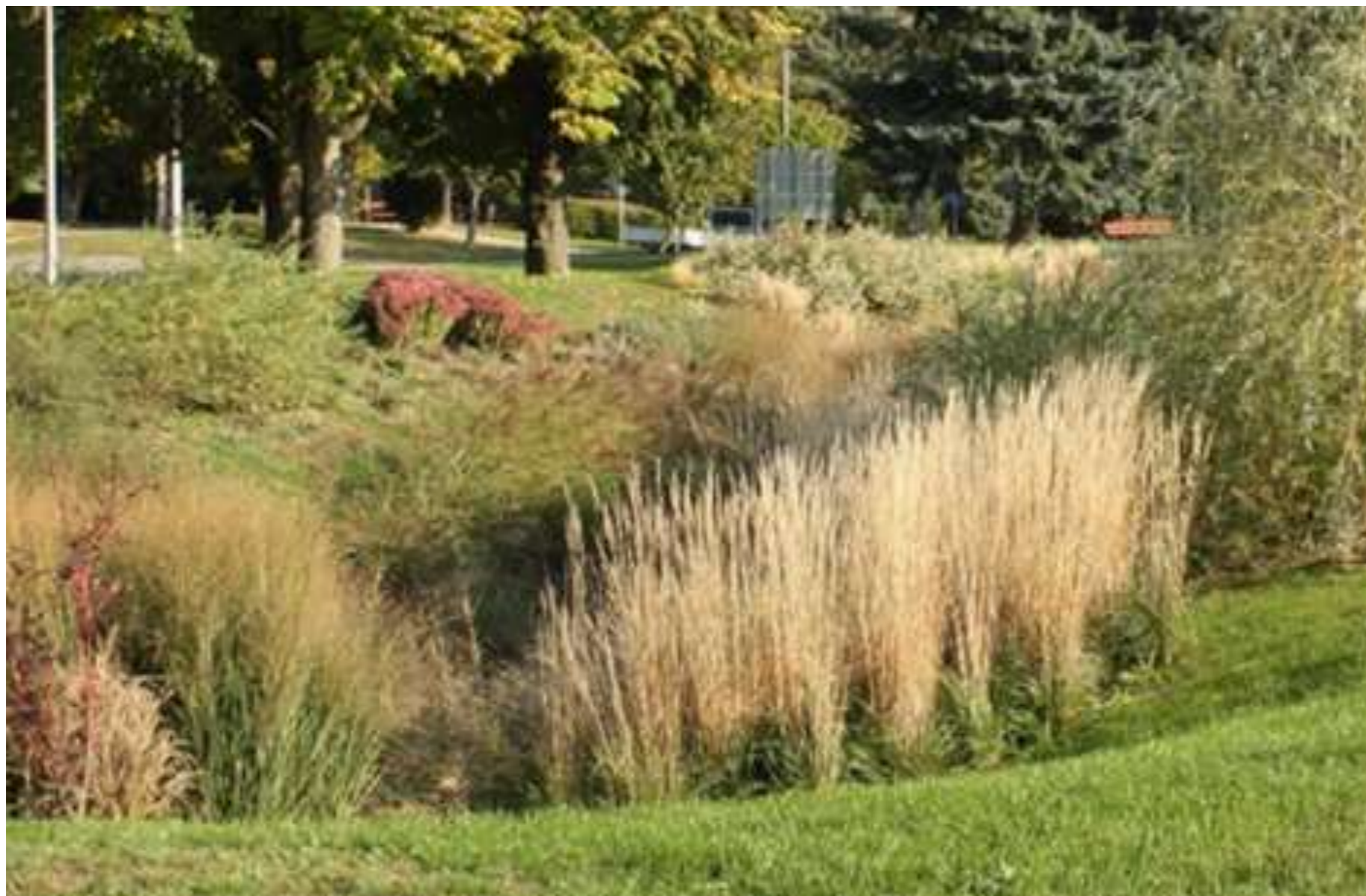
Fotó: Zalakaros gyógyhely komplex turisztikai fejlesztése” című projekt keretében, annak részeként valósult meg a SUDS (Sustainable Urban Drainage System)
