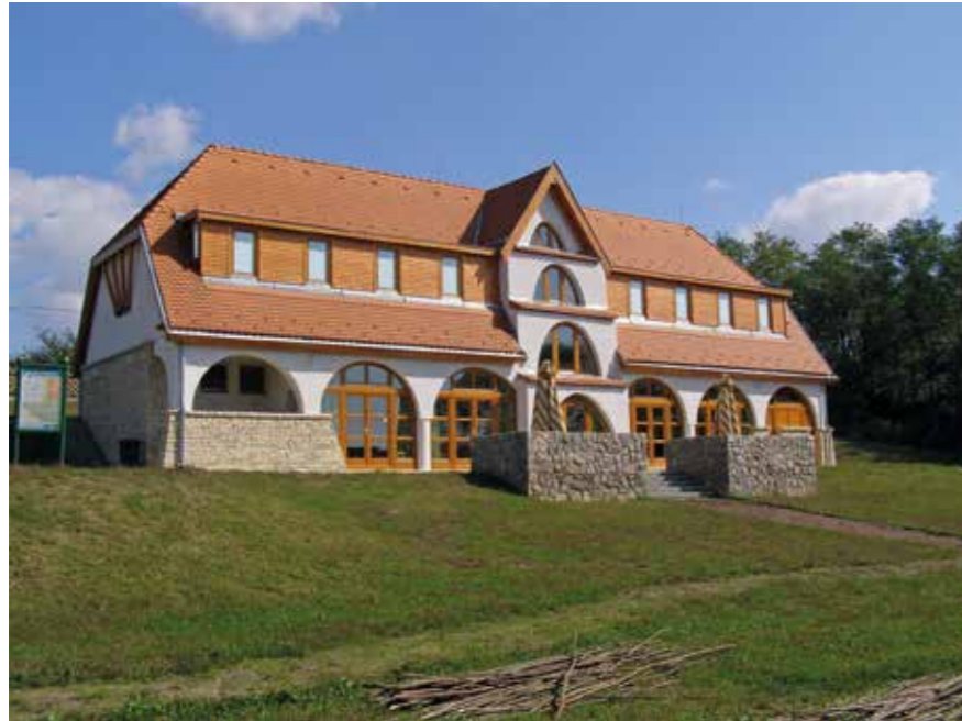
▼ Duna-Dráva Nemzeti Park igazgatósági épületek, Drávaszentos. Építéset: Dévényi Sándor, Halas Iván, 2000–2006. Fotó: Dénes Eszter
